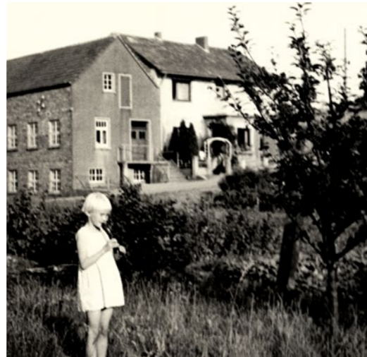
Wohnhausaufstockung, Horst Finkemeier
